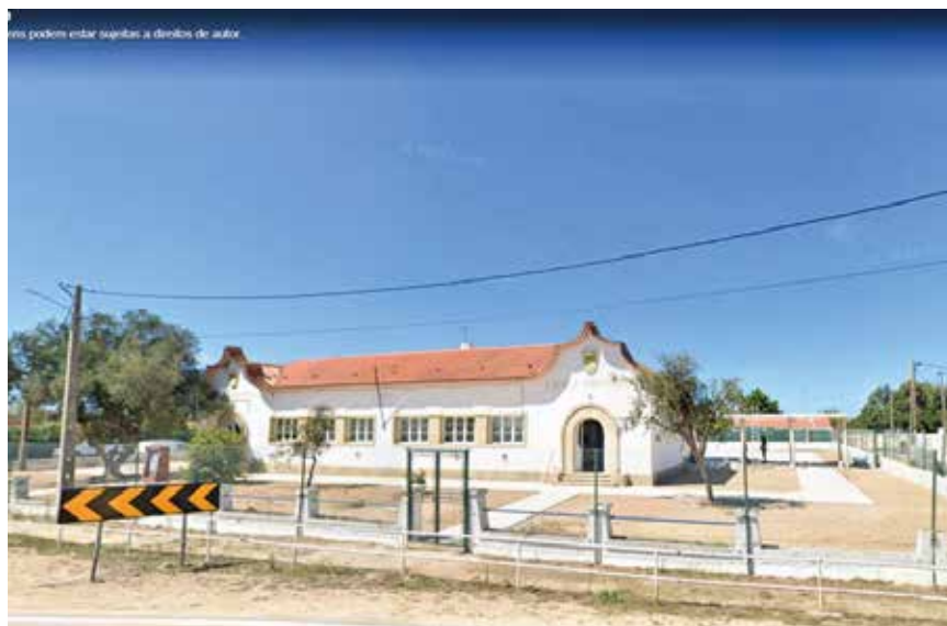
A escola localizada na Vila das Brunheiras reabilitada pelos fuzileiros
